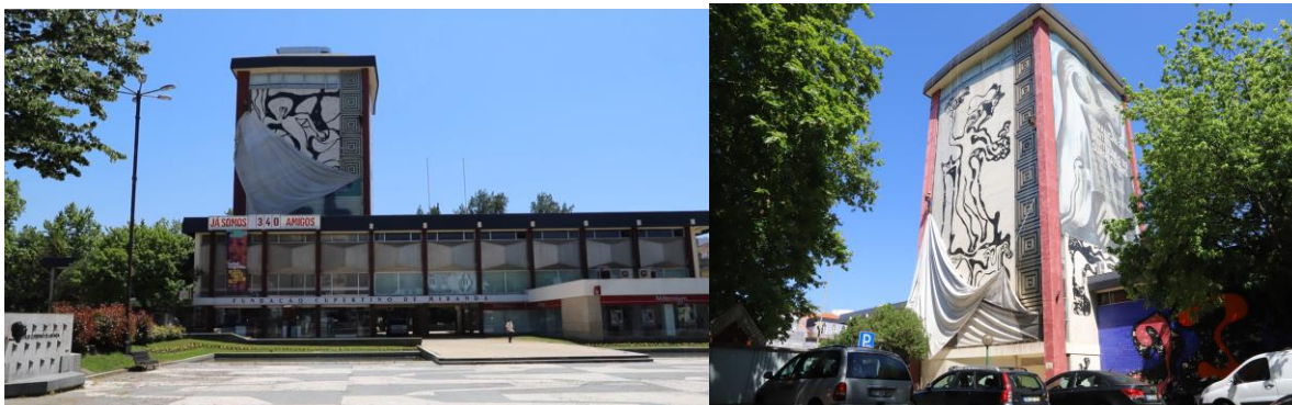
Imagens: Desmontagem das lonas nos painéis Norte e Sul, respetivamente.
